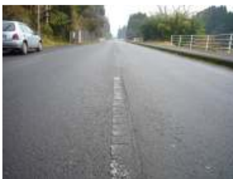
<県道の路面ラインが消えて危険でした。>
