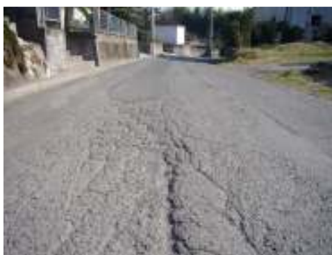
<路面の傷みがひどく、 デコボコの状態でした。>
