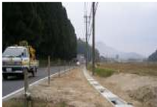
(県道の歩道舗装)
