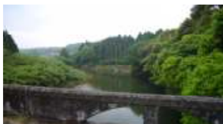
樋脇川の寄り洲除去と倒木除去
