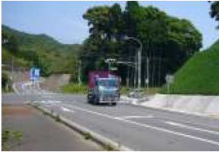
県道の角切り整備済み (H 2 0) <国道 3 号から 川内港 への十文字 : 県道京泊草道線>
