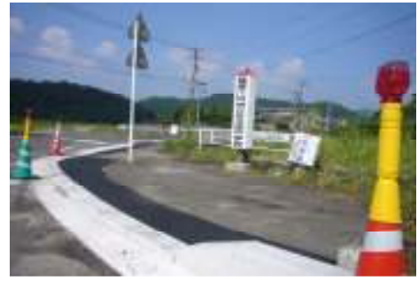
【市道部分も拡幅工事中～ 信号機は 1 1 月に設置予定。】
