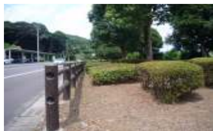
【国道267号線の除草】
