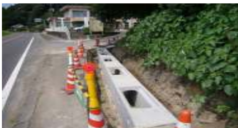
八幡コミセン前の排水対策も 工事着工されました(県事業)。
