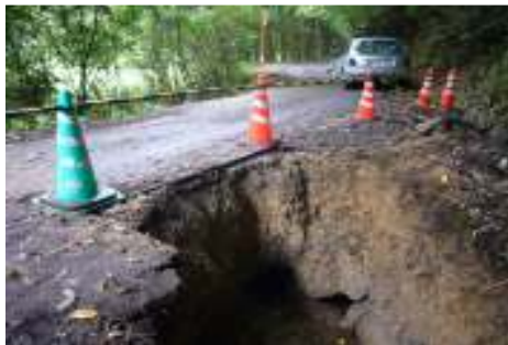
<災害箇所の工事>
