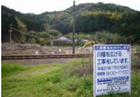
<草道川の災害復旧工事 ～人家が被災する寸前でした。>
