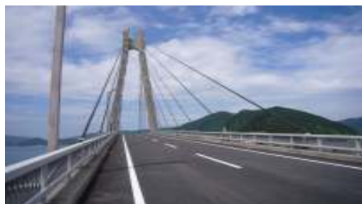
甌大明神橋の老朽化した 転落防護柵の改修【甌島（上甌町）】
