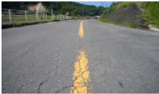
<県道の舗装改良～東郷西方港線>
