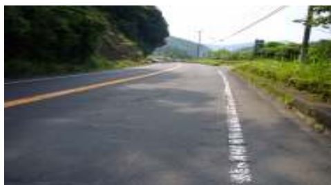
<国道328号（県管理）の舗装改良 ～北薩と鹿児島市の幹線道路です。>
