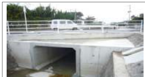
【橋梁の長寿命化対策です。 ～久見崎町（滄浪地区）】
