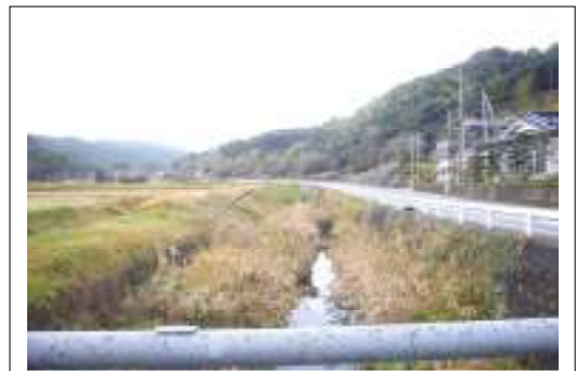
<麦の浦川：一条殿橋下流～高野橋上流 ～現況：寄り洲に草木が繁茂しています。> ※麦の浦橋、小園橋付近も要望済みです。
