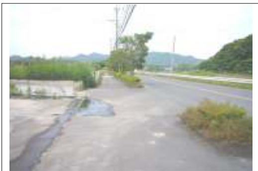
<歩道の排水対策：県道草道京泊線>
