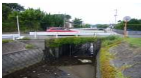
<汐入橋の改修（県道川内串木野線） ～本会議で整備要望しました。>
