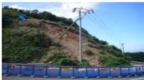
<甑島：県道の（坂道）急カーブで ガケくずれ災害>
