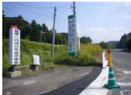
(着工後～関連の県道・市道の工事中)
