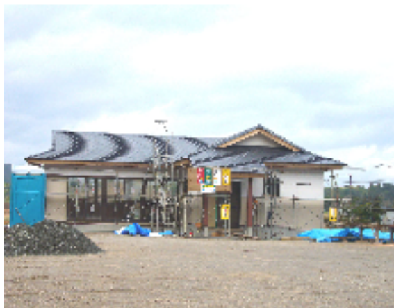
< H 2 4 . 1 2 / 2 2 ~近隣地に建設中>
