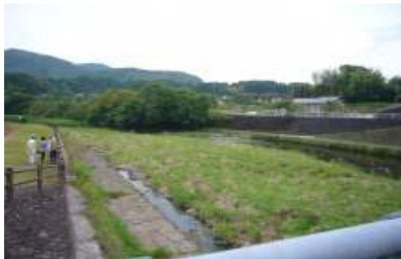
< 樋脇川に堆積した大量の寄り洲 ～ 入来町清色地区 >
