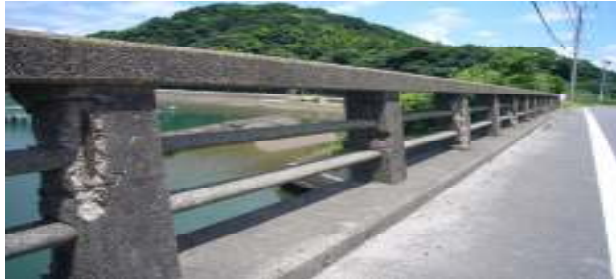
<老朽化で鉄筋がむき出しの状態。地域防災計画の避難経路。>
