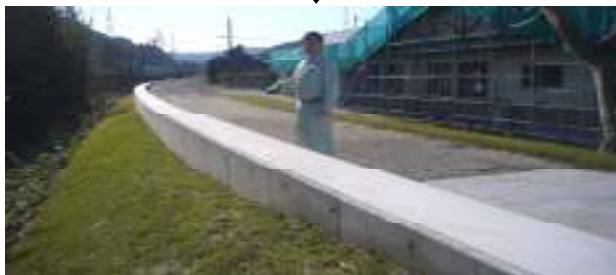
【H 2 4 ～ 2 6 の継続事業で、長い区間、コンクリ護岸が整備済み。～ あさひ保育園付近】
