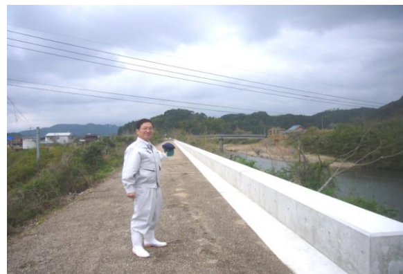
(H24から継続的に整備中 ～中村橋上流)
