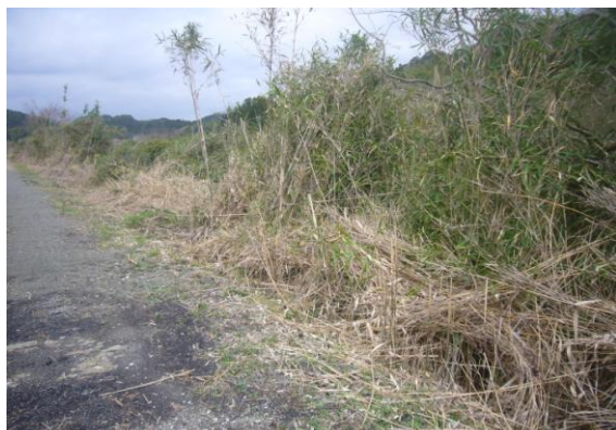
(平佐東地区の浸水対策 ～樋脇川の堤防「カサ上げ」を要望)
